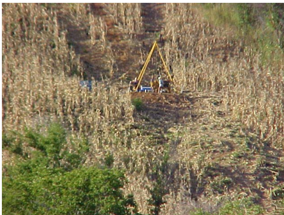
Foto 13-004 – Execução de Sondagens
